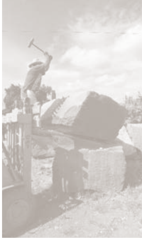
Extracción y corte de bloque de piedra de recinto
